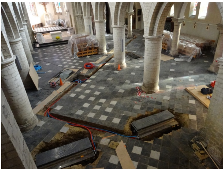
Petit aperçu d'une partie des travaux.
